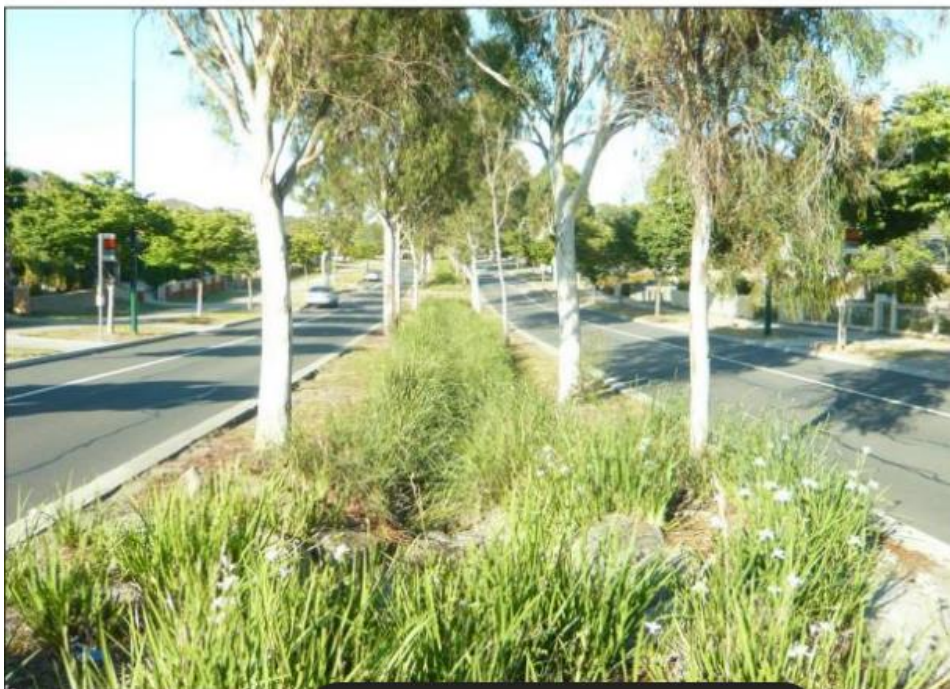
Figur 4-5 Exempelbild av biofilter i vägsektionen från Svenskt Vattens rapport Utformning och dimensionering av anläggningar för rening och flödesutjämning av dagvatten. Övre bild: skiss på tvärsektion, undre bild: fotoexempel.
