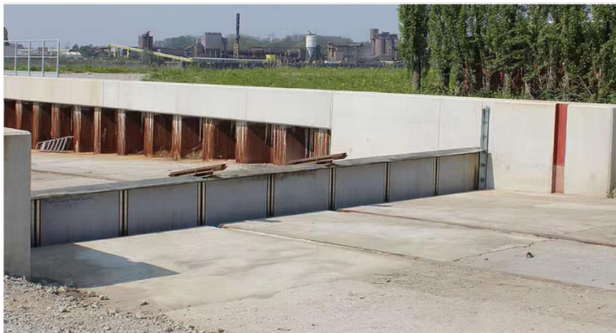
Figur 3-12 Exempel på skyfallsport som kan skära av flödesvägen ner till tunneln (Flood control international, 2024).
