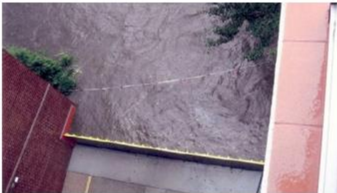
Figur 4-9 Tillverkare FloodBreak skyddar garagedfart till ett flerfamiljshus i Great Neck, NY (A Better City, 2015).
